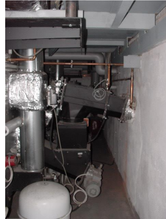
Brennstoffeintrag am Kessel
