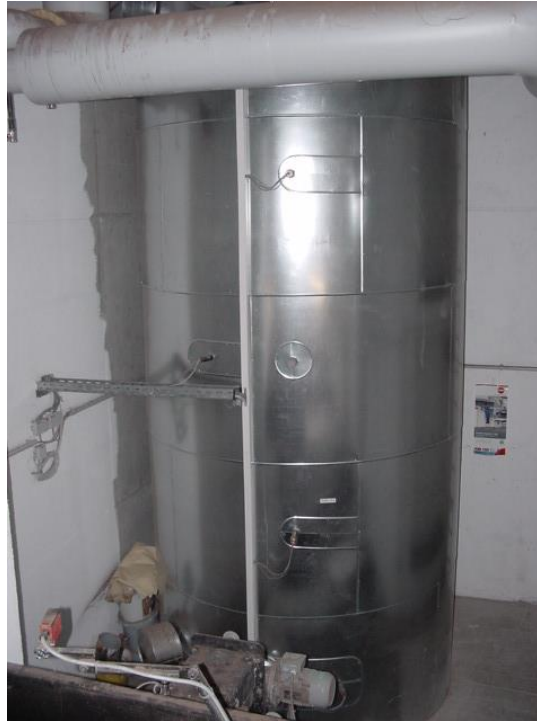
Brennstoffeintrag am Kessel
